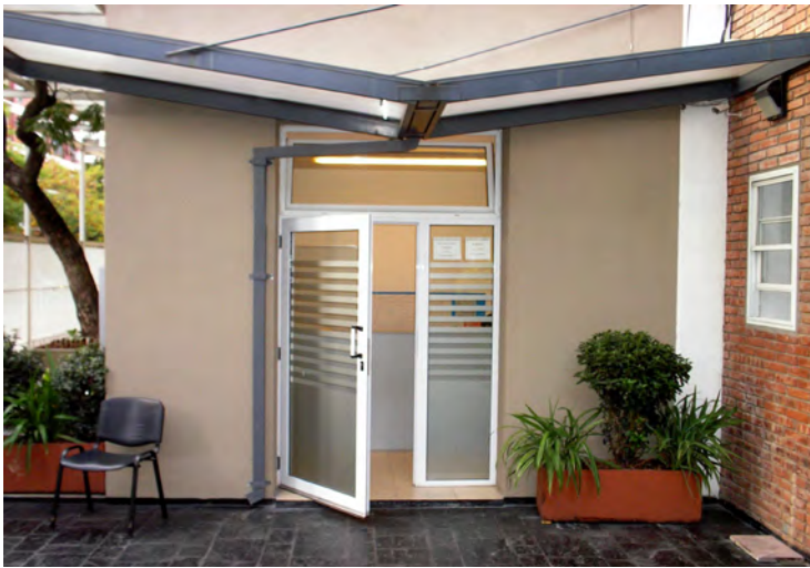
Nueva entrada a la recepción.
